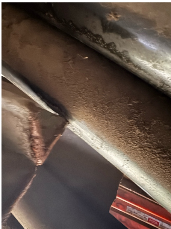
5 – možný vznik plášťové poruchy, vlivem dilatace mostní konstrukce
