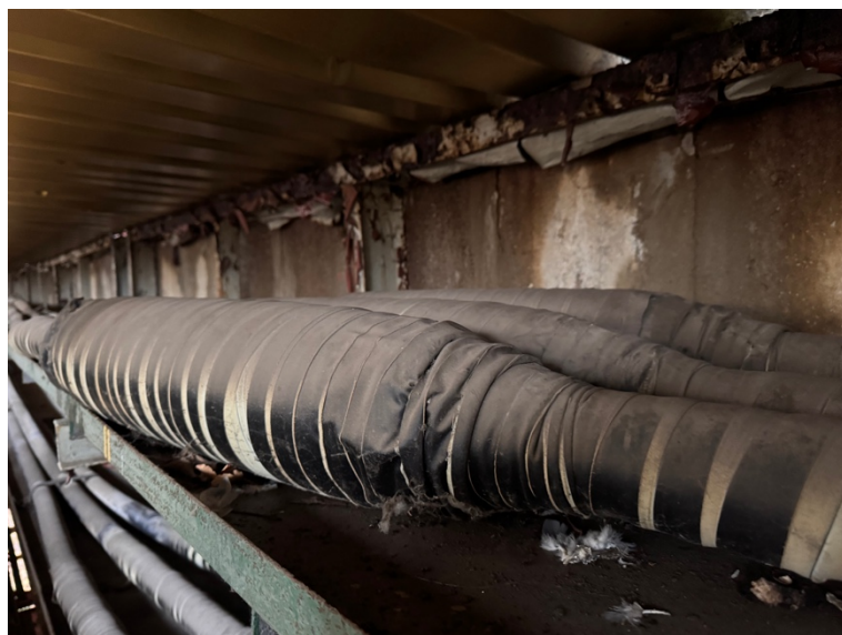
2- nevhodné umístění spojek
