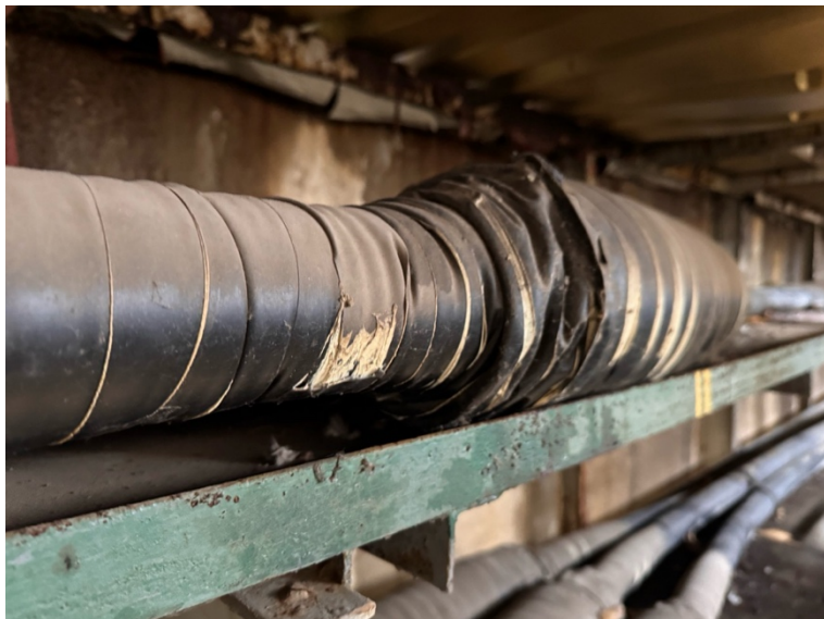
1- nevhodně umístěná spojka, bez přichytek
