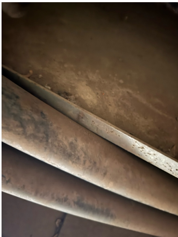
3 - nevhodné umístění kabelů na lávce
