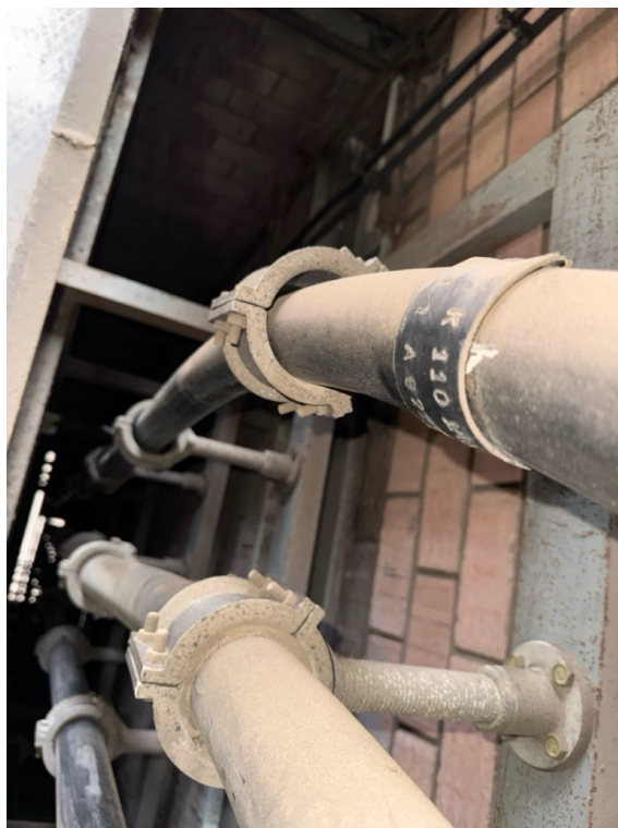
4 - chybějící gumové vložky svorek zapříčinily sesunutí kabelu o 30cm
